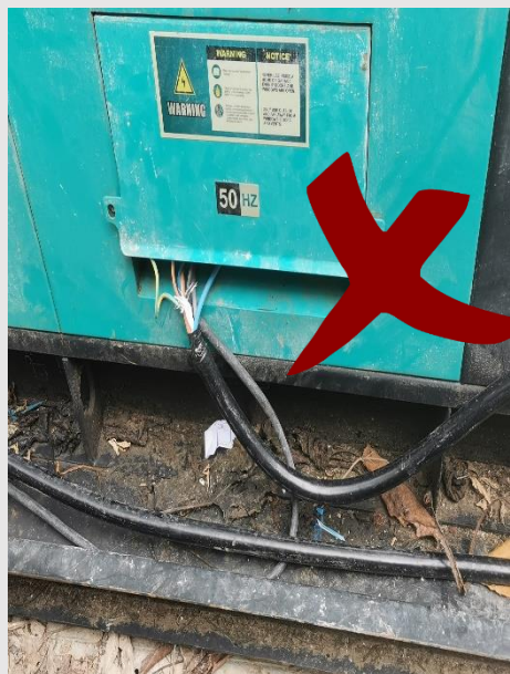
電工具本身沒有經過 任何保護裝置而直接 接駁至臨時發電機取電
