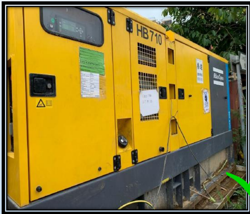
發電機設置接地水線
