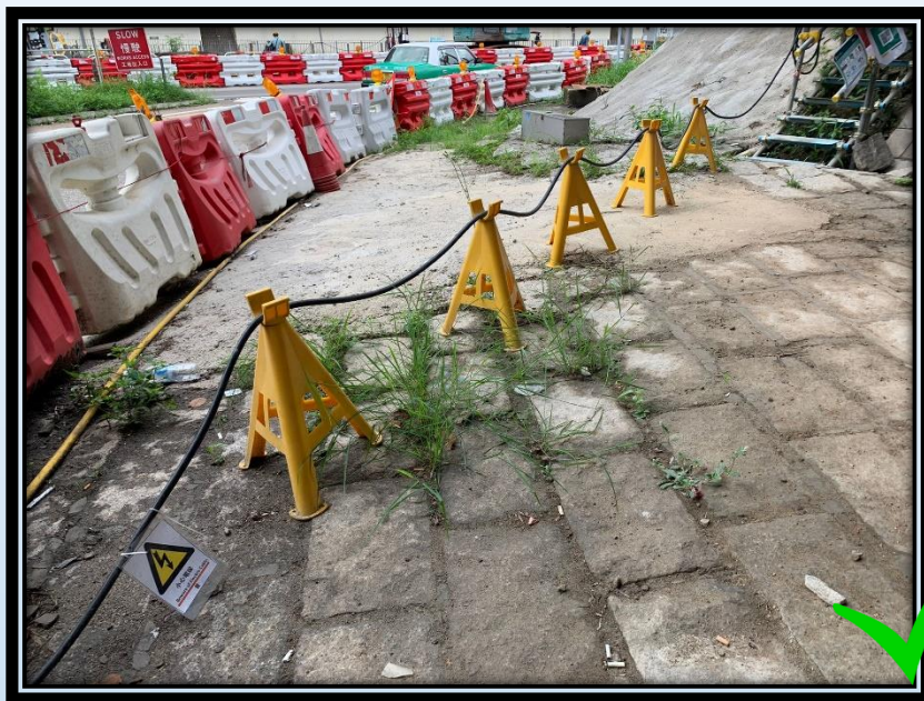
使用絕緣支架鋪設電線，以免電線拖地
