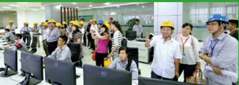
媒体采访团参观合肥垃圾发电厂中控室
