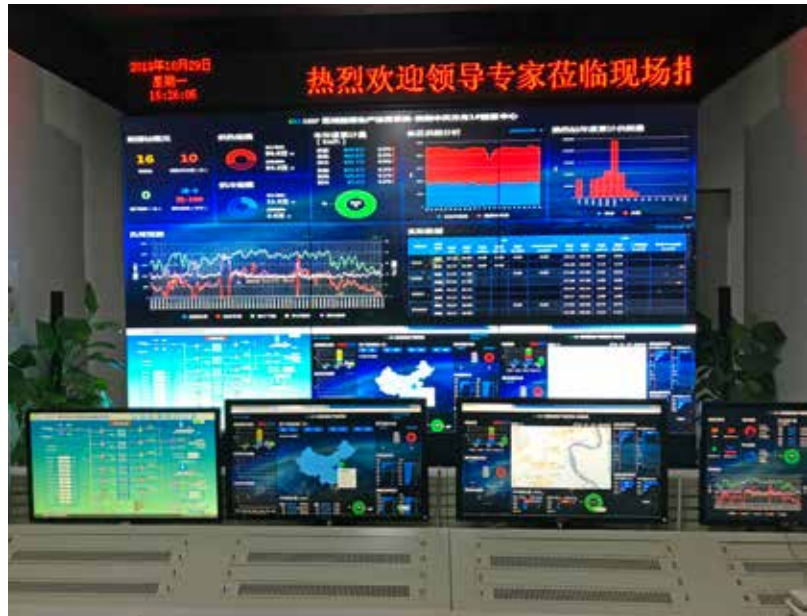
中节能（贵州）建筑能源有限公司供能项目中控室
