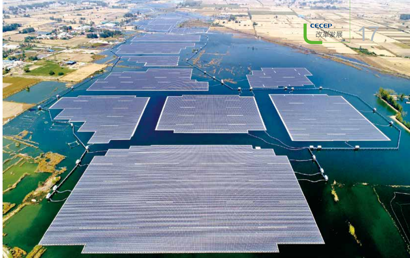
中节能安徽埇桥区采煤沉陷区朱仙庄 70 兆瓦水面光伏电站项目
