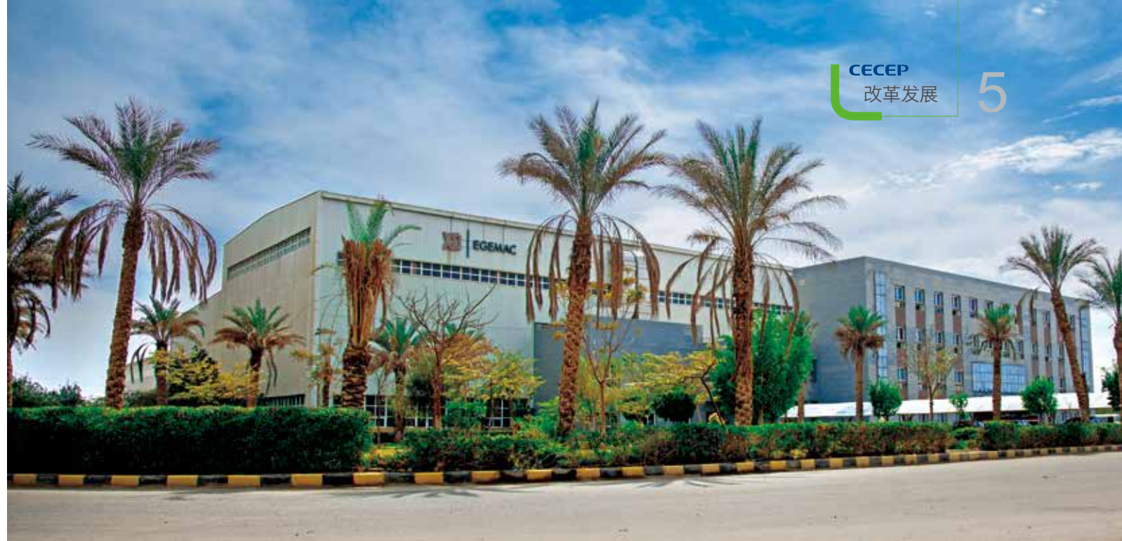
西电埃及 EGEMAC 高压电气有限公司 220kV 变压器厂
