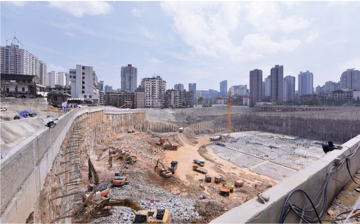
▲ 位于贵阳老城区的贵医污水处理厂正在紧张的施工中。这项工程是全国首例、亚洲最大的深基坑开挖污水处理厂，由于喀斯特地貌的石灰岩结构，必须采用爆破和碎石机联合作业。
