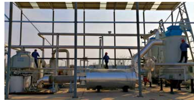
▲ 中环装备医疗废弃物处置装备“应急尖刀队”成员调试安装设备。
