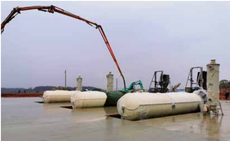
▲ 2 月 14 日高温蒸煮设备吊装完成。
