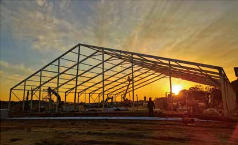
▲ 2 月 17 日建筑钢架搭建完毕。
