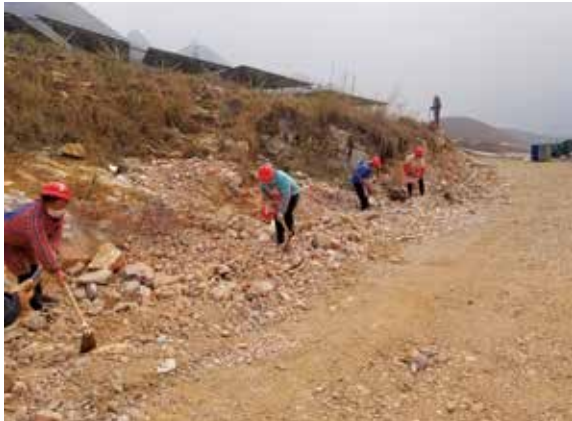
▲ 太阳能公司关岭项目正全力以赴“促建设、稳生产”，光伏区各项建设工作有序开展，道路施工、围栏安装等工作如火如荼进行。
