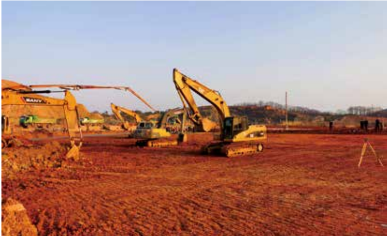
▲ 2 月 9 日项目基础开挖。
