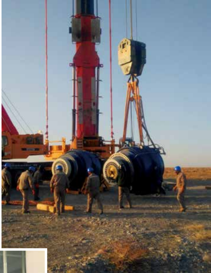
▲ 2月23日，风电公司下属甘肃区域公司昌马风电场大坝项目32#齿轮箱完成更换。
