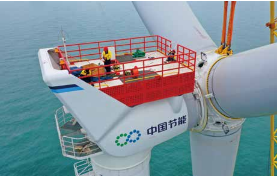
▲ 风电公司阳江海上风电项目首台 5.5 兆瓦风机吊装成功。
