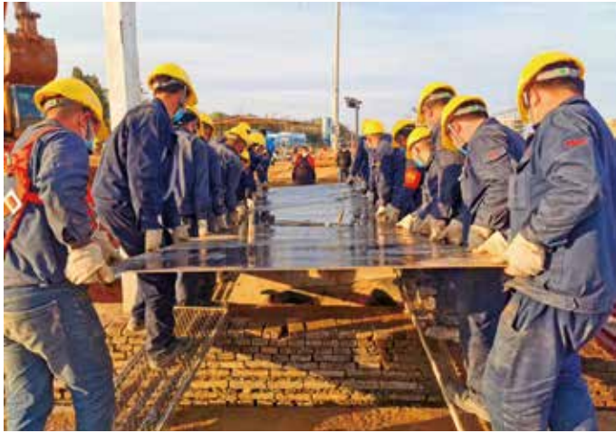
◀ 武汉医疗废弃物应急处置中心的基建工地上，工人们正日夜抢工、紧锣密鼓地建设。
