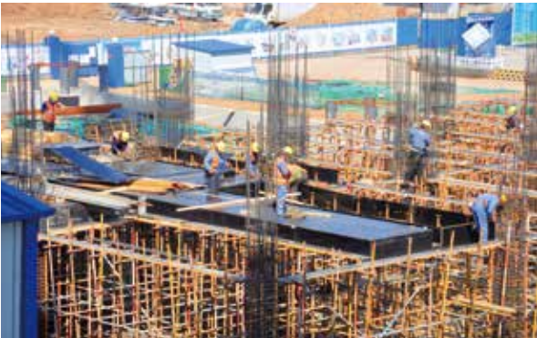
▲ 中国环保下属沧州公司垃圾处理不断档，项目加速推进。垃圾发电二期工程的建设工地已动工，工人们正在绑扎钢筋、焊接预埋件。
