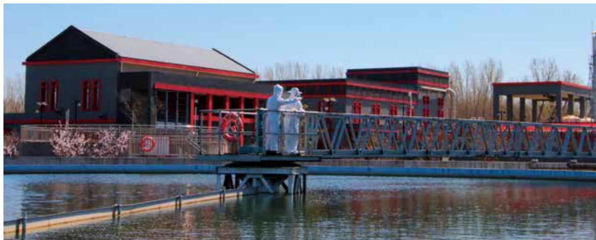
▲ 昌平公司小汤山再生水厂负责小汤山医疗废水管控，在废水排污管道施工现场，员工和施工方商讨DN800供水主管保护方案。
