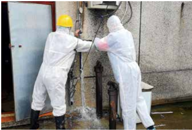
▲ 2 月 28 日，襄阳中环水务市政工程公司抢修人员正在川惠酒店隔离区抢修内部管道。
