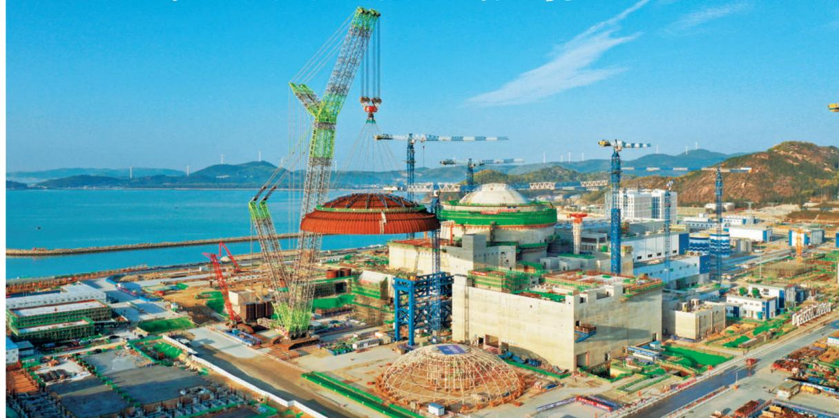
本报讯（记者白宇）2月17日，我国自主三代核电“华龙一号”批量化建设首台机组——中国核工业集团有限公司漳州核电厂1号机组穹顶成功吊装，标志着该机组主体结构工程施工完成，为后续安装冷芯及并网发电奠定坚实基础。
