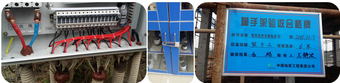
图 8 太阳能公司江西莲花电厂汇流箱内接线规范、使用防火泥封堵 图 9 江西公司安义污水处理厂化验试剂陈列柜双锁管理 图 10 中地集团江西泰和项目脚手架挂验收牌
