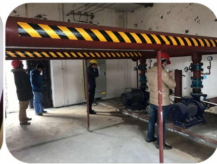
图 8 西中区安全部门赴大荔公司环保检查
