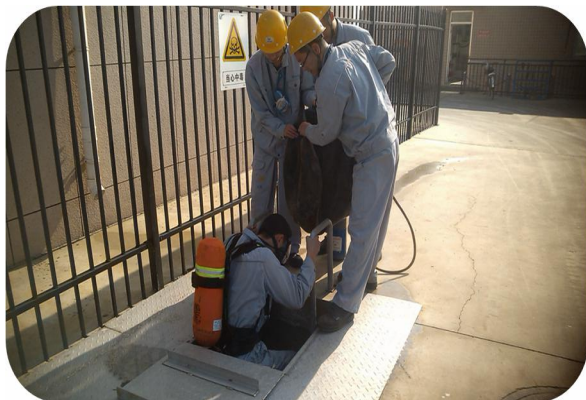
图8 万润公司 - 罐区泄漏应急演练 封堵总排口
