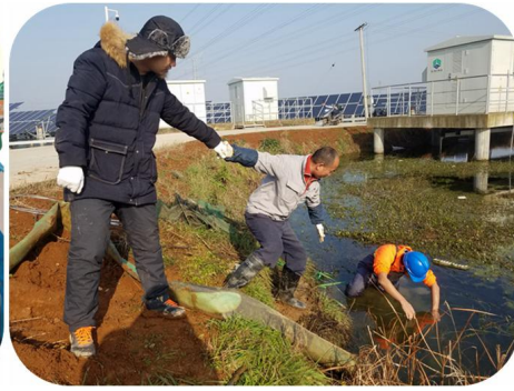
图 6 华东区长兴公司 - 架设临时排水泵前清除杂草
