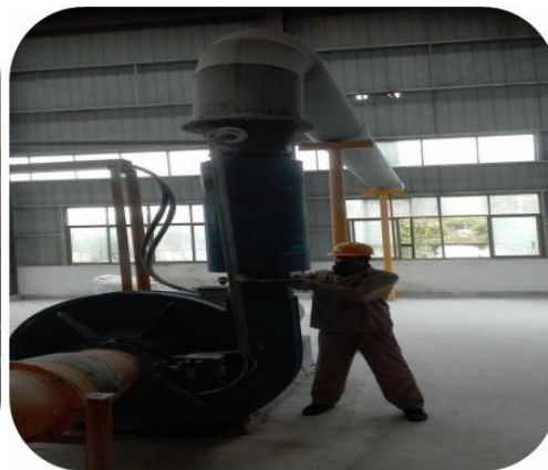
图 10 江西公司-检修消音器
