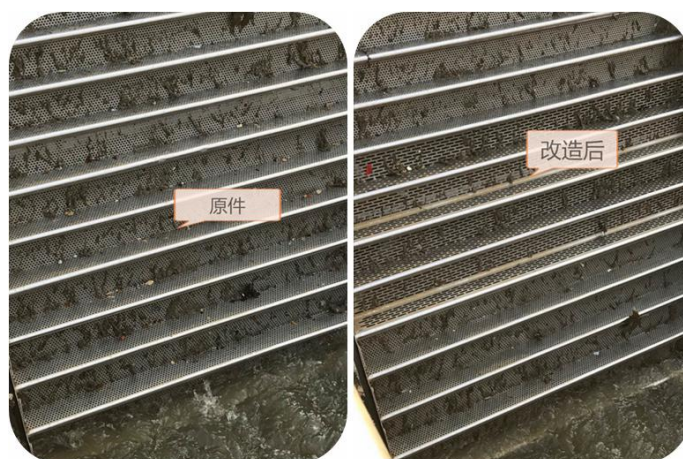
图 4 蚌埠污水 - 技术改造（改造前、后） 解决细格栅堵塞、卡阻、易变性等问题
